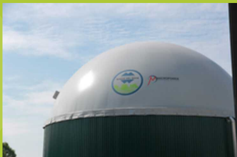
Figura 2-1 Digestare per biogas
